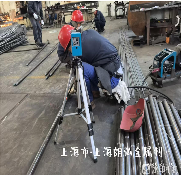
注：电焊操作位
